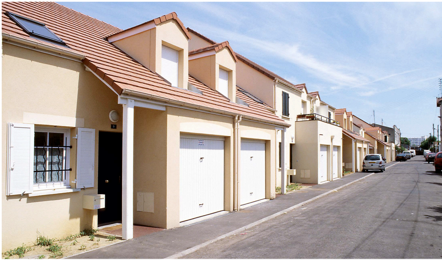
IMPASSE PIERRE DEGEYTER, LOGEMENTS IMMOBILIÈRE 3F, source: Ville de Montreuil
