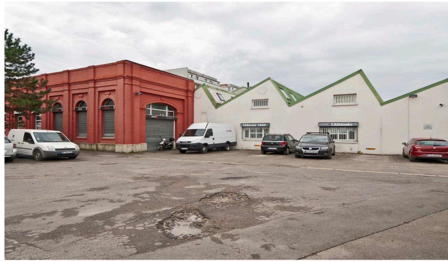
CAP SIGNAC, 17 RUE DE LA FERME, source: Ville de Montreuil
