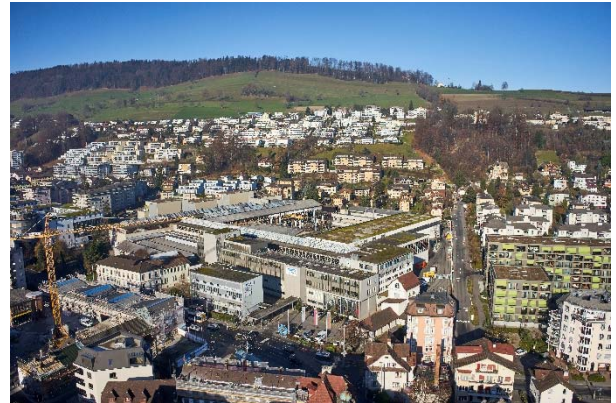
2016 –Andritz-Areal. Auf dem Schappe Areal steht heute ein Einkaufszentrum.
