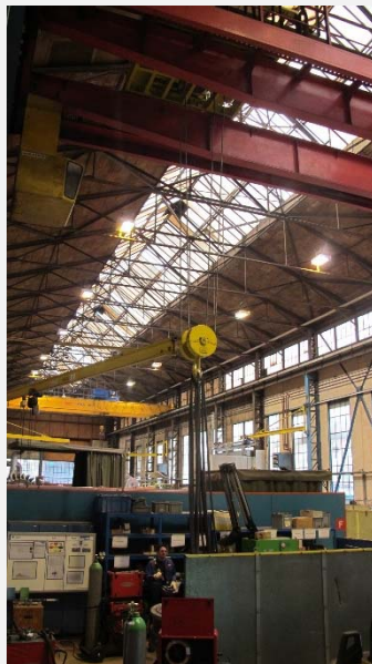
Halle 8 – rechte Wand ist die Aussenfassade West der Halle 7
