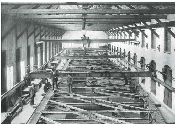
Dans les ateliers de Kriens, on a assemblé et démonté plus de 600 ponts ferroviaires et routiers avant de les remonter sur place. Cela a été par ex. le cas en 1909 de la plus longue poutre-treillis en acier de l'époque (120 mètres) qui a servi à la construction du chemin de fer Bodensee-Toggenburg (photo avant 1909, rec. H. P. Bärtschi)
