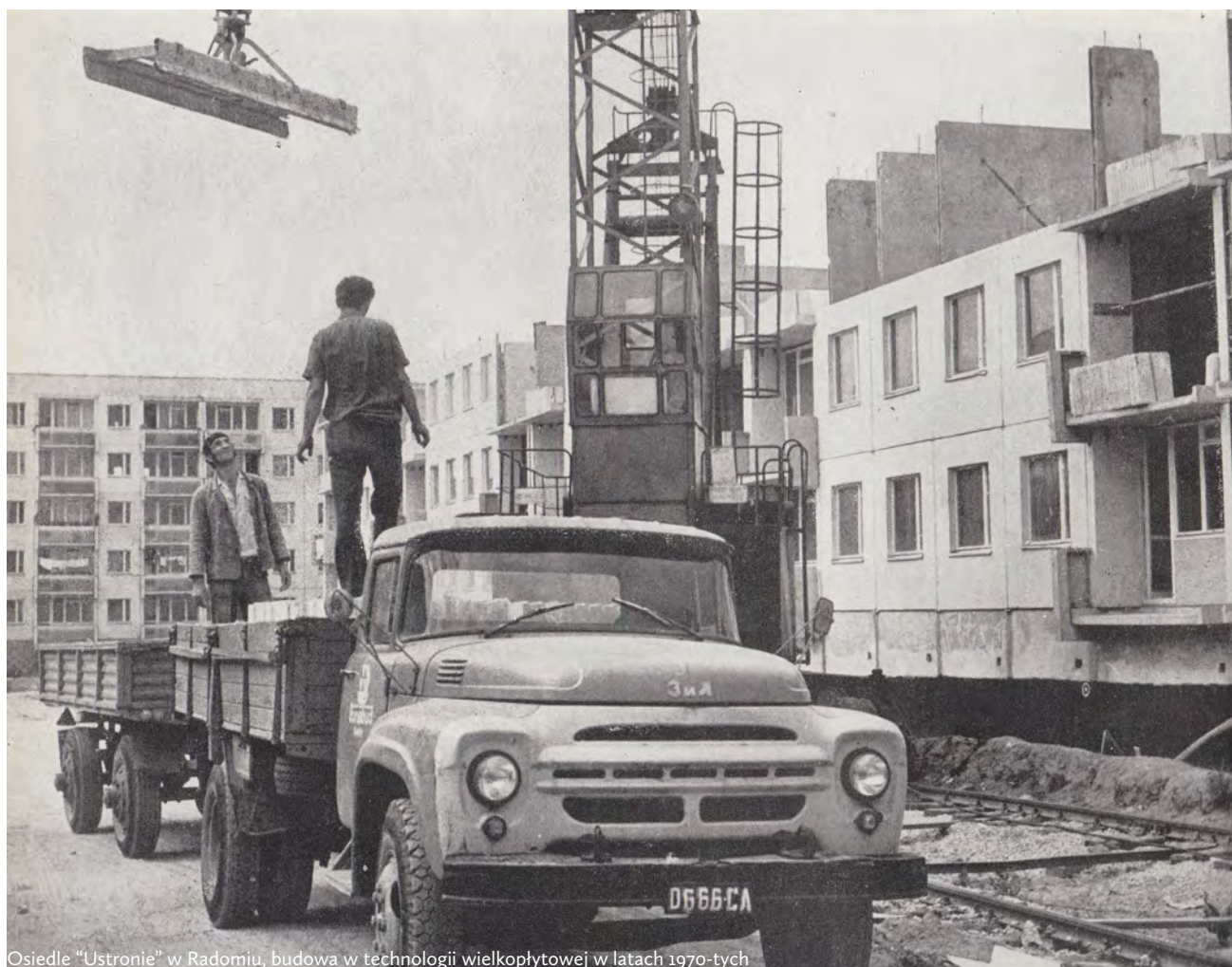
Osiedle "Ustronie" w Radomiu, budowa w technologii wielkopłytywowej w latach 1970-tych
