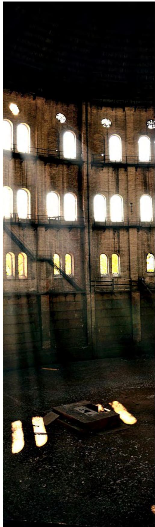
Wnętrze zbiorników gazu Gazowni Miejskiej na Woli
