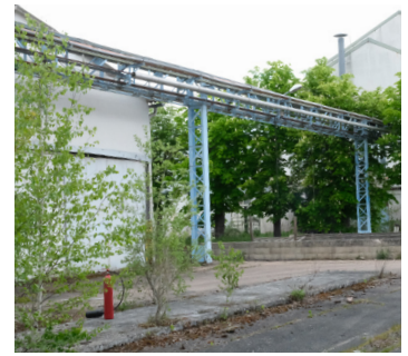
Photo prise sur site
