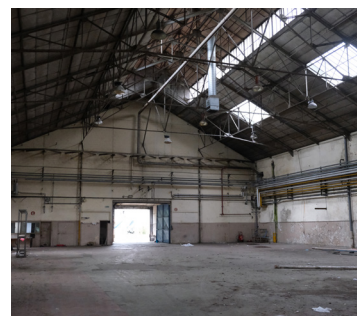
Photo prise sur site - hangar propice au démontage
