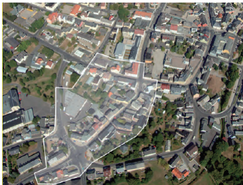
en haut SELB E11 (DE) : vue du site en dessous GETARIA E11 (ES) : vue du site
