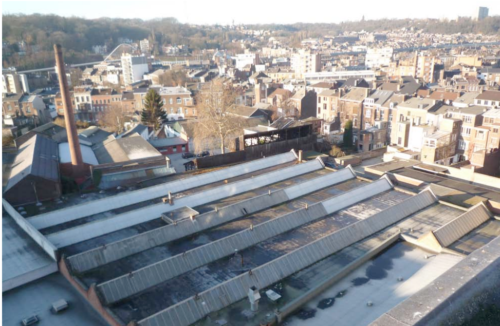
Toitures de l'îlot
