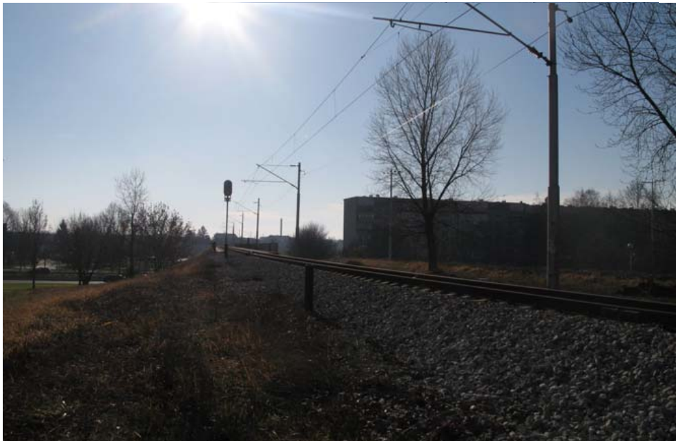
Blick auf die Eisenbahnlinie
