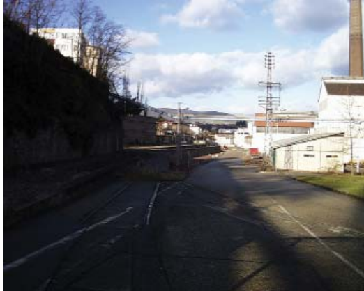
Les murs de soutènement qui bordent le site à l'ouest
