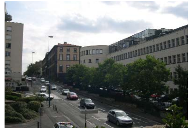
Bd Lagarlaye, Blick entlang der Nordfassade – Zahnmedizin
