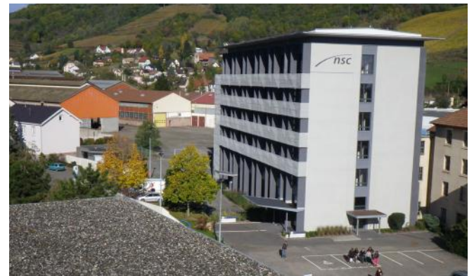
Bâtiment 36, immeuble de bureaux, îlot NSC
