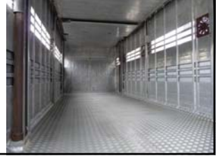
Lavado de vehículos mediante agua fría y caliente a alta presión
