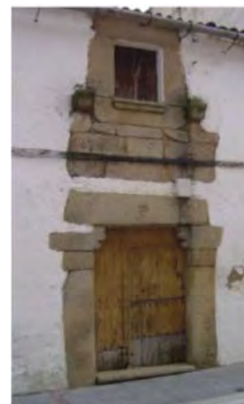
Img 5. Fachada, C/ Larga
