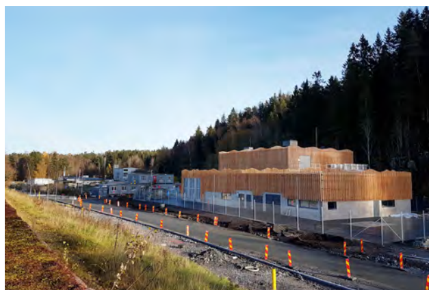
Gässlösvägen och nybyggd pumpstation vid gamla reningsverket
