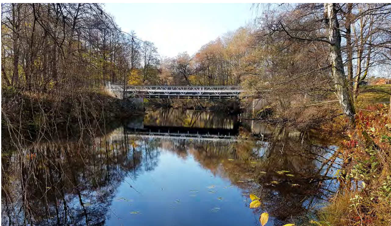
Ledningsrör över Viskan mellan Gässlösa och Göta
