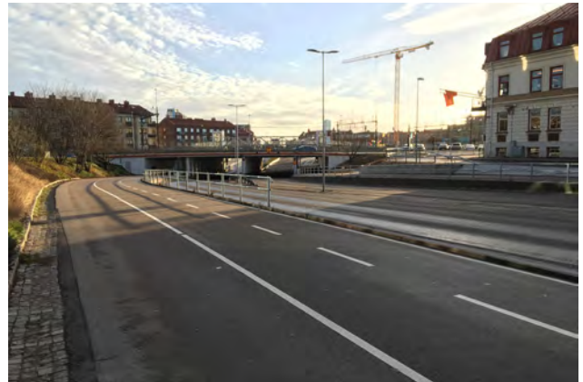
Tunnel under spåren sedd från Viktoriagatan
