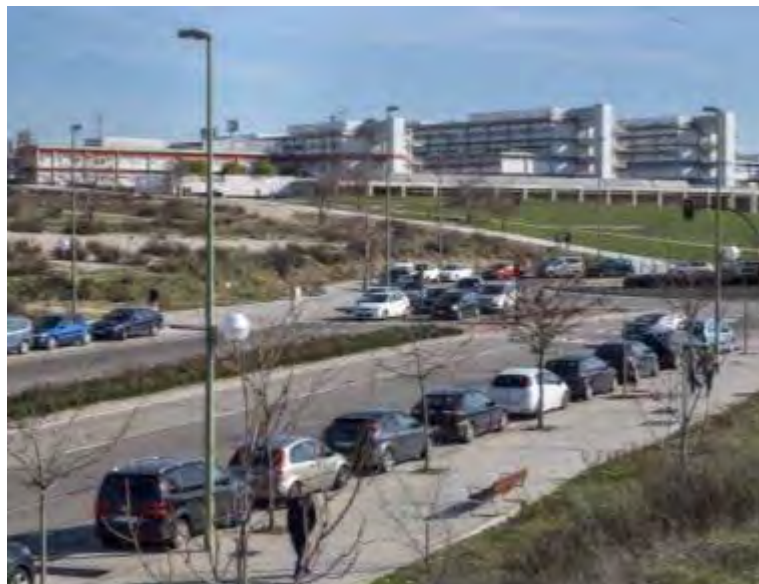
19. Gran Vía del Este access to Infanta Leonor Hospital
