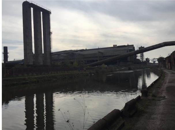
Les quais de halage étaient les anciennes zones de déchargement des wagonnets du chemin de fer. Pour faciliter le déchargement, le chemin de fer surplombait les quais. Les parties métalliques seront démantelées, les murs de soutènement en béton seront maintenus.
