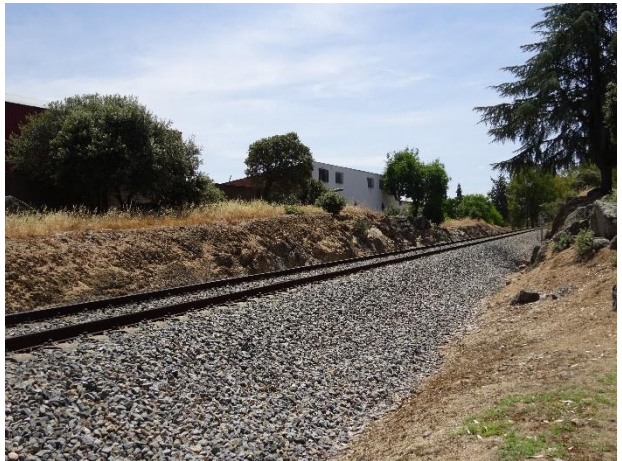
VÍA DEL TREN_VISTA HACIA EL NORTE
