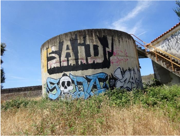
ANTIGUAS INSTALACIONES PANTANO DEL COJUGE
