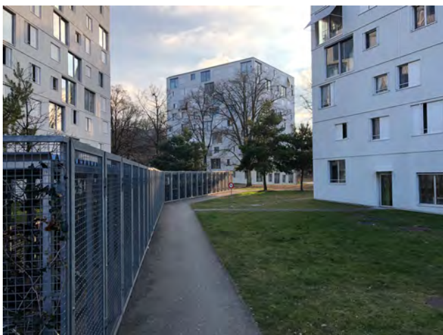
Fig. 43 Cité Auréa et ses stationnements vélos sécurisés
