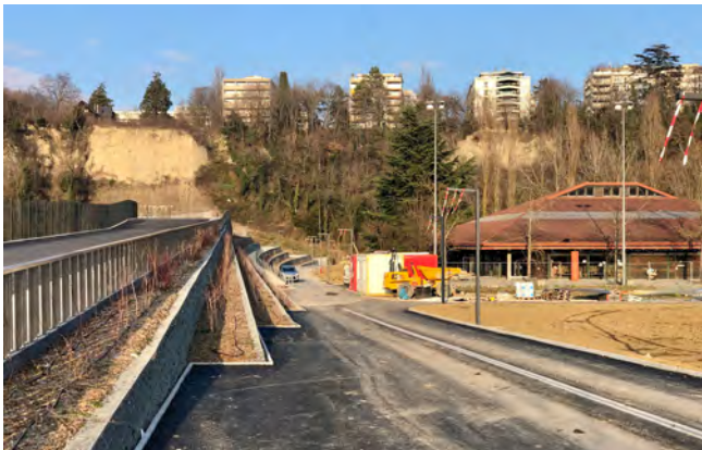
Fig. 32 Toit du pont des Artisanes (ouvert à la mobilité douce) et boulodrome (à droite)
