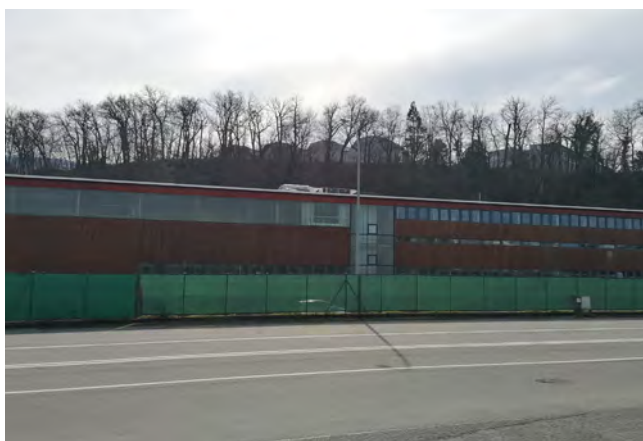
Fig. 23 Le bâtiment de la voirie (4B), la moraine au loin (2B), la piste d'entraînement au premier plan (4A)
