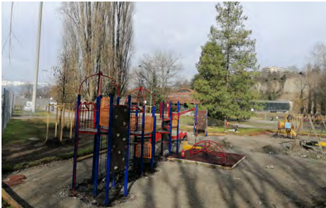
Fig. 30 La place de jeux (en travaux) et l'espace de grillades
