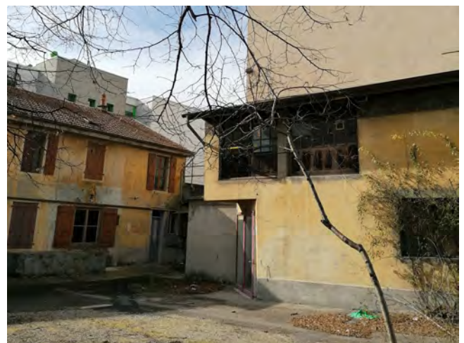
Fig. 42 Cour entourée de bâtiments à restructurer (5F)
