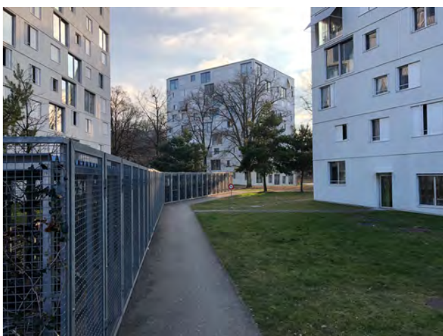
Fig. 43 Cité Auréa et ses stationnements vélos sécurisés
