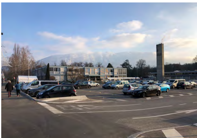
Fig. 33 Service des automobiles (un des bâtiments administratifs au loin)
