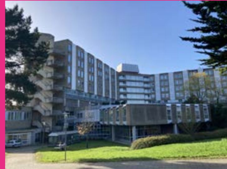
Vue sur le bâtiment principal
