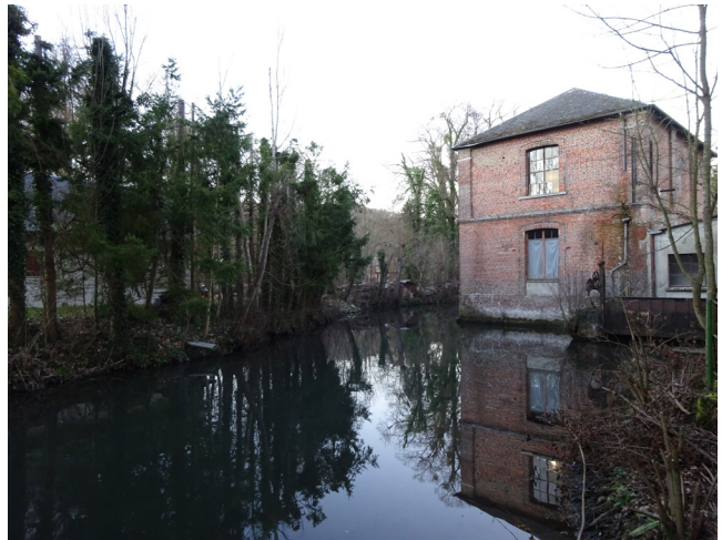
ANCIEN MOULIN, SITE DE COURCELLES, FONTAINE-L'ABBÉ FR-INTERCOM_BERNAY_TERRES_NORMANDIE-PS4-P10
