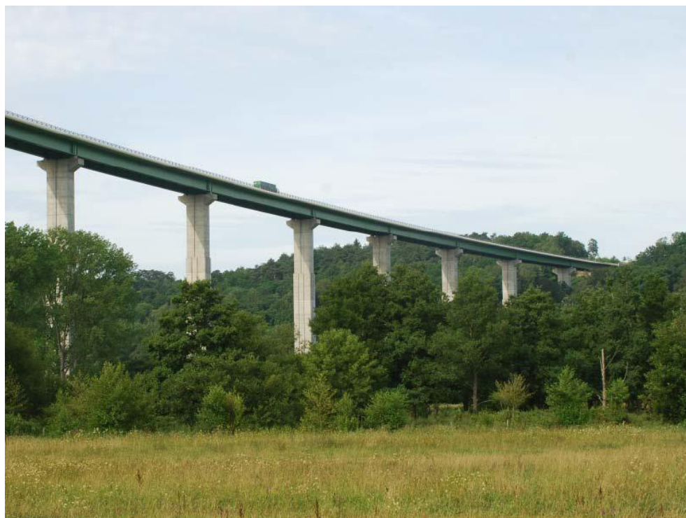
L'AUTOROUTE A28 TRAVERSANT LA VALLÉE DE LA RISLE GRÂCE À D'IMPOSANTES INFRASTRUCTURES (COMMUNE DE CALLEVILLE) (Atlas des paysages de Haute- Normandie)
