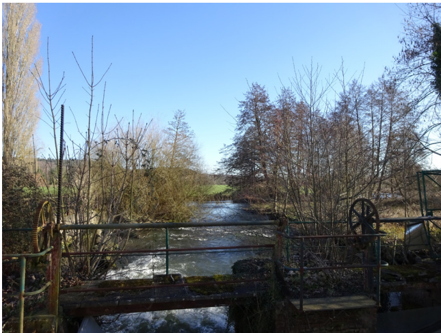
OUVRAGE HYDRAULIQUE, SITE DU PETIT NASSANDRES, SERQUIGNY FR-INTERCOM_BERNAY_TERRES_NORMANDIE-PS3-P11
