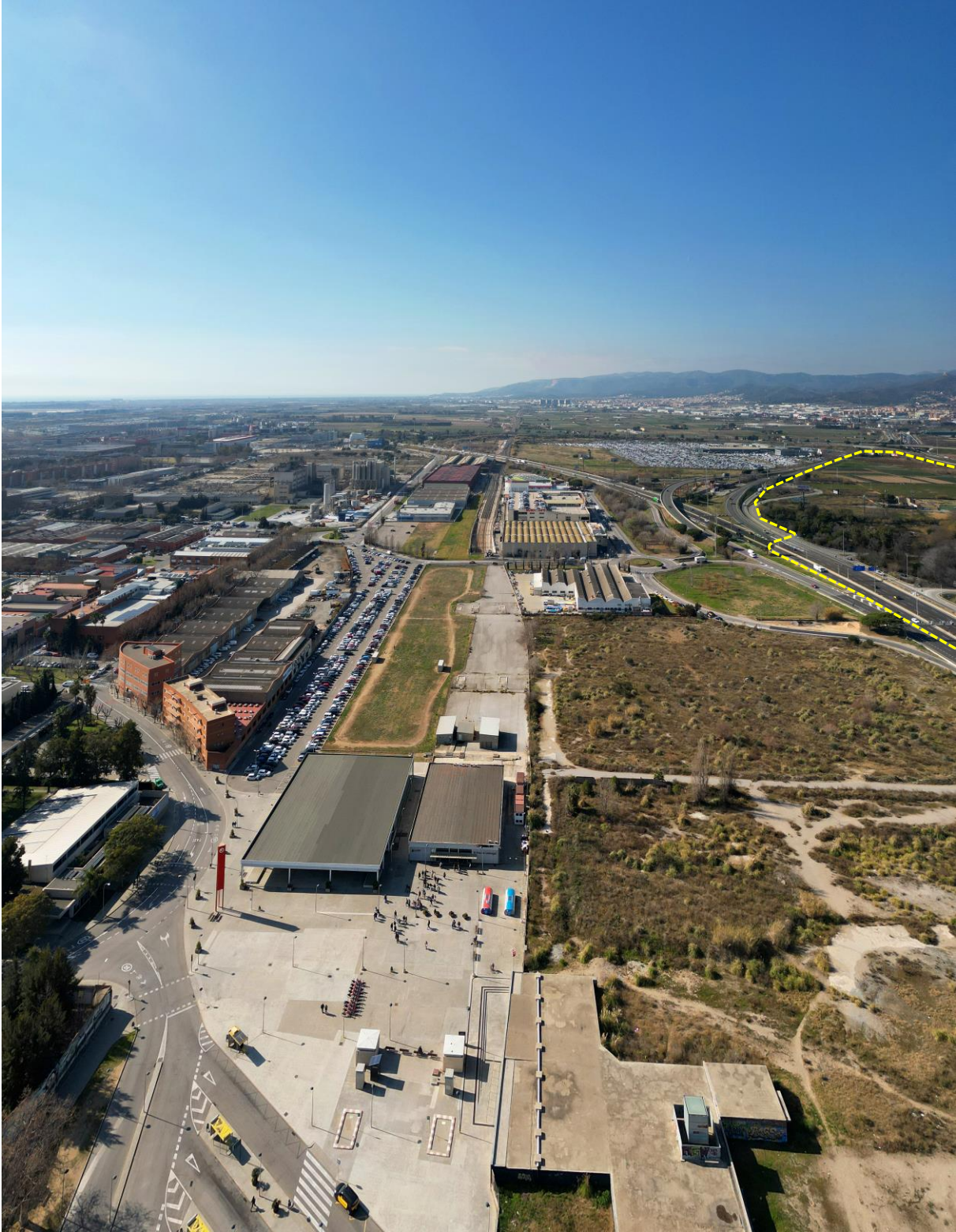
9. Estación de Ferrocarril Cercanías R2. Emplazamiento a la derecha. Núcleo urbano a la izquierda.
